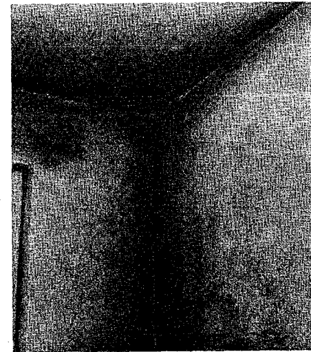
Abb. 9. Kondenswasserbildung an Decke nahe der Aussenwand und in Aussenwand-ecke. Tropfenbildung und Pilzbestedelung.
