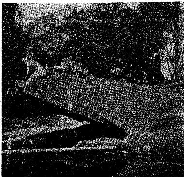
Fig. 1. Engelsk buebro i armeret murværk.
